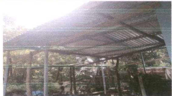
FOTO 18: MODULO 2 BODEGA, CUBIERTA DE LAMINA
