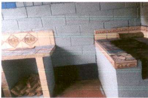
FOTO 9:MODULO 2 REPARACIÓN DE COCINA Reparación de azulejo en muebles de cocina
