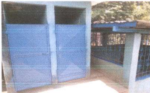
Foto 5: SERVICIOS SANITARIOS Y SUS ACCESORIOS Mantenimiento a estructura (lijado, cambio de tubo, cepillado, sujeciones, aplicación de pintura) a puertas servicios sanitarios
