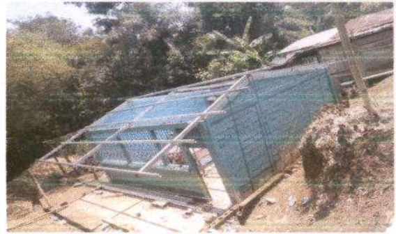
FOTO 14: CUBIERTA DE LAMINA
