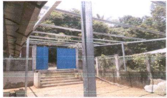
FOTO 8 MODULO DE PATIO CUBIERTA DE LAMINA ESTRUCTURA DE TECHO
