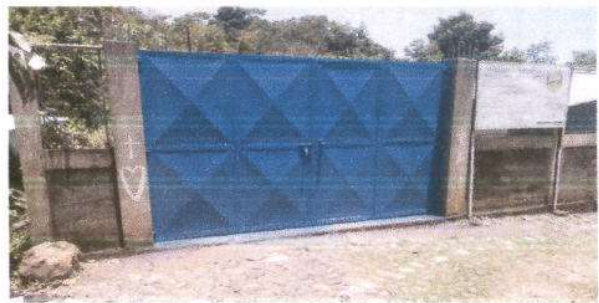
Foto 4: MANTENIMIENTO A PORTONES MODULO 1
