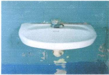
Foto 7: Sustitución de lavamanos
